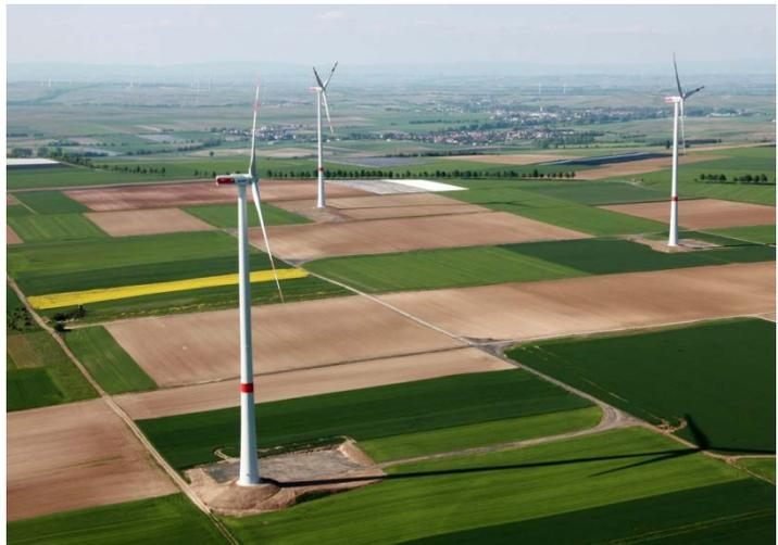
Die Anlagenleistung des Windparks beträgt 10.200 kW insgesamt (3.400 kW pro Anlage). Somit kann an diesem Standort im langfristigen Mittel mit einem Jahresertrag von 19.600.000 kWh gerechnet werden. Die 3 Windenergieanlagen können umgerechnet ca. 5.600 Haushalte jährlich mit Strom versorgen.
